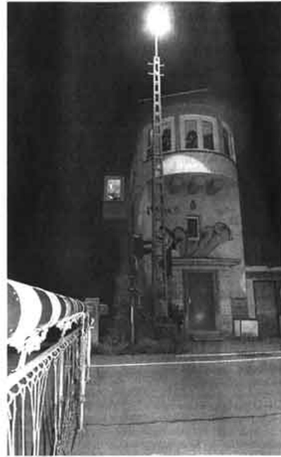
Vom heutigen Esszimmer aus - links im Bild - konnte der Fahrdienstleiter einst die Strecke überblicken. Per Hand wurde dann die Schranke gekurbelt.
